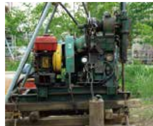
【ボーリング調査】
