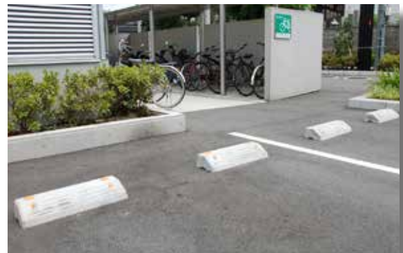
■庄原市新庁舎駐車場整備工事■ 広島県 庄原市役所 (ST-100)
